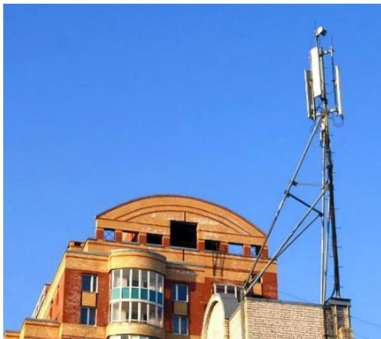
Рисунок 10 – Пример типичной городской базовой станции сотовой связи
