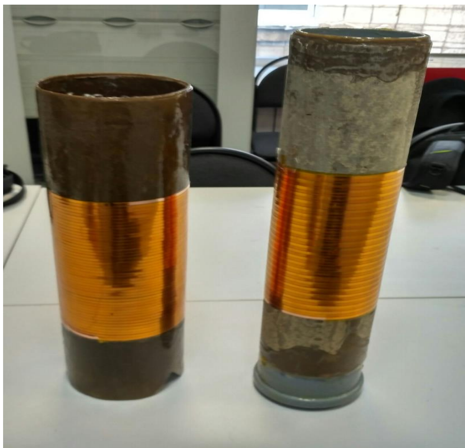
Рисунок 5.22 – Обмотки высокого (слева) и низкого (справа) напряжений ВТСП трансформатора
