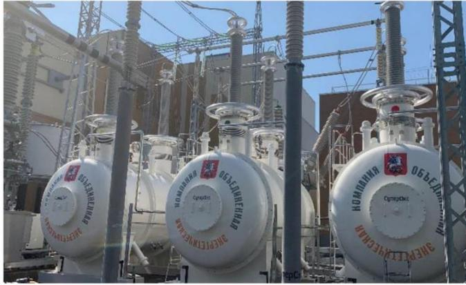
Рисунок 1.10 – Сверхпроводящий ограничитель тока КЗ на подстанции «Мневники» Мосэнерго 220/20 кВ (вид спереди)
