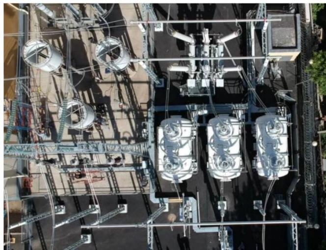
Рисунок 1.11 – Сверхпроводящий ограничитель тока КЗ на подстанции «Мневники» Мосэнерго 220/20 кВ (вид сверху)
