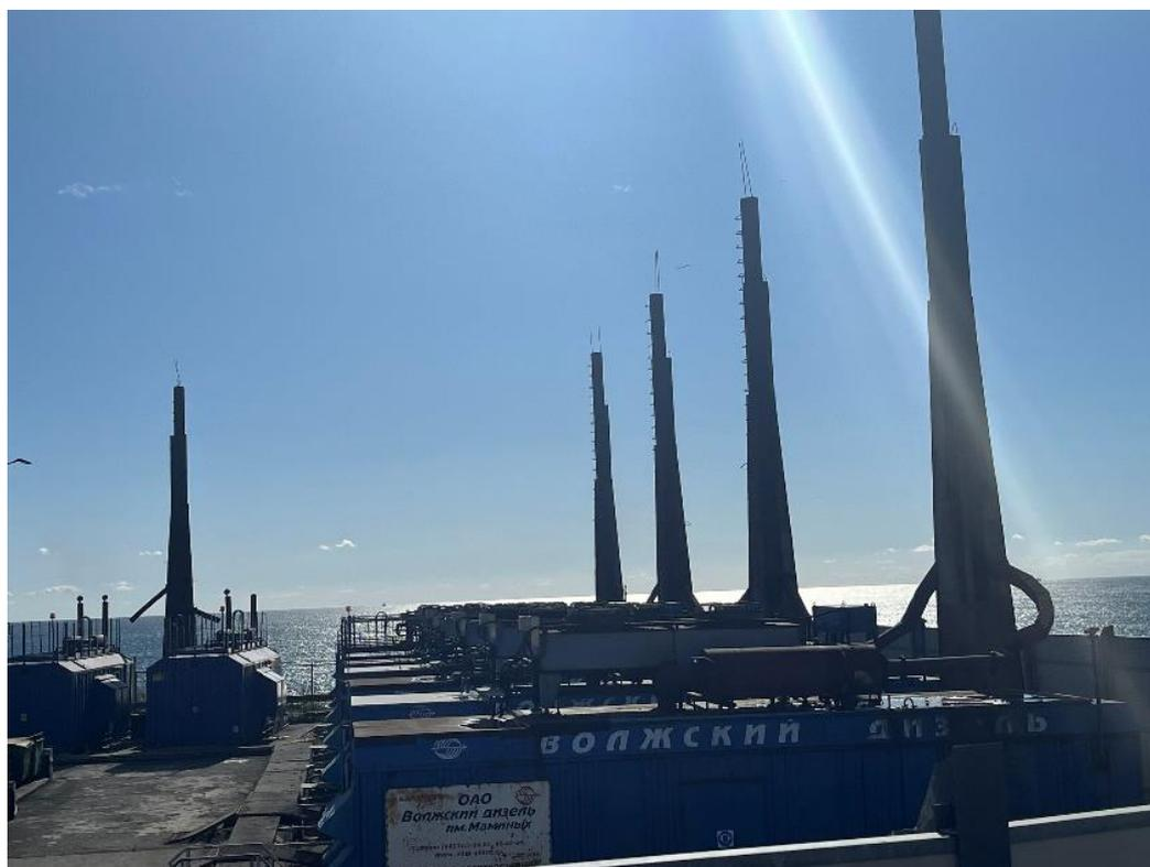
Рисунок Г.2 - Внешний вид блочно-модульных дизельных электростанций типа ЭД520-Т6300-2РН (ДЭ80 (4x520 кВт))
