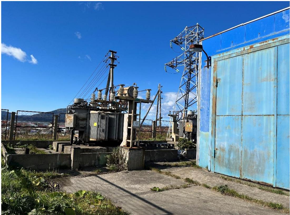
Рисунок Г.7 - ЗРУ-35 кВ, открытая установка трансформаторов на распределительной подстанции 35/6 кВ
