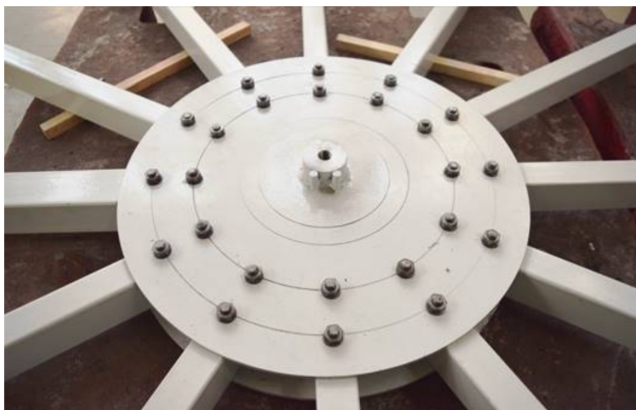
Рисунок 4.13 — Узел крепления зонтичного каркаса
